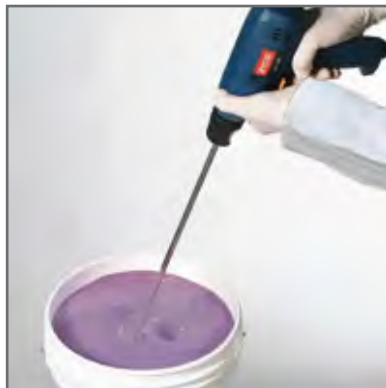
۱ مخلوط کردن لعاب با استفاده از همزن
