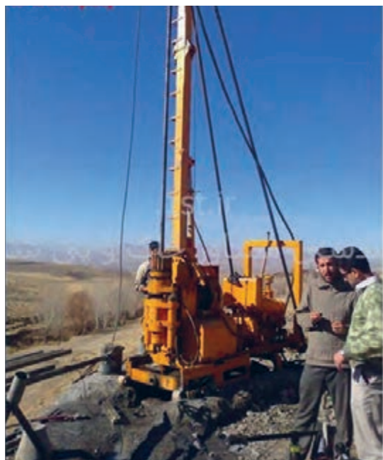
دستگاه حفاری مستقر شده بر روی فونداسیون
