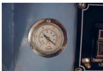
شکل ۴-۱۸- روشن کردن پمپ وکیوم
