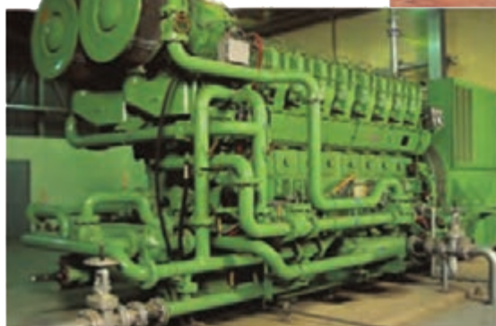
موتور ژنراتور یک نیروگاه برق اضطراری معدن
